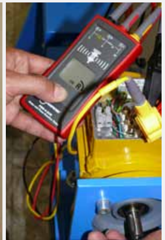
Kontrollera motorrotation före anslutning
